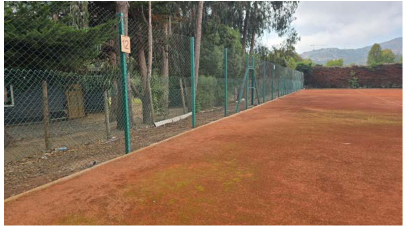
Reemplazo pilares reja norte de las canchas de tenis N° 11 a 14
