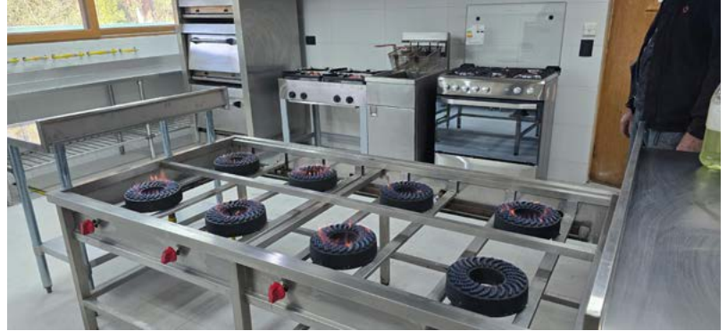
Remodelación de la Cocina
