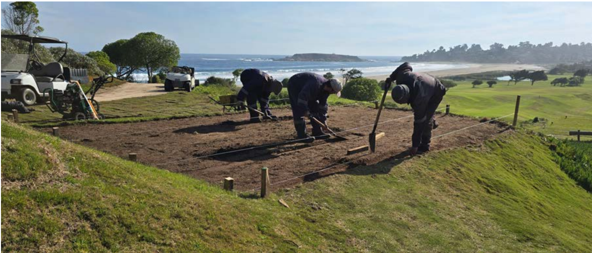
Trabajos de nivelación de un tee
